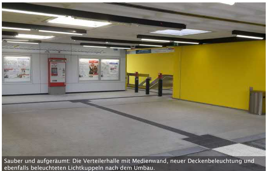
Der Charakter des U-Bahnhofs Scharfreiterrung als Ingenieurbau ist nach wie vor zu erkennen, doch insgesamt wirkt er nach der Umgestaltung viel ansprechender.
